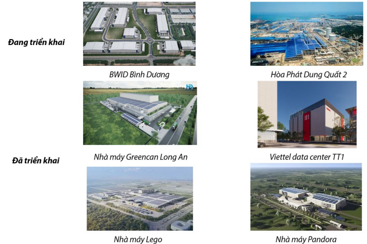
Hình 35: Một số dự án công nghiệp lớn mà CTD đã & đang triển khai
